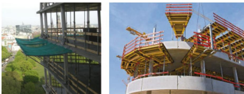
Bild 3. Absturzsicherungen in unterschiedlichen Bauphasen Bildquelle links: eigene Aufnahme; rechts: Peri GmbH
