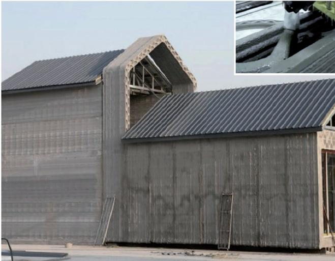
Bild 7. Aus gedruckten Grundelementen zusammengesetztes Haus der Firma Windsun [1]
