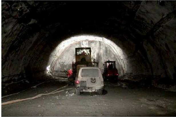
Bild 2. Eingeschränkte Sichtverhältnisse im Tunnelbau
