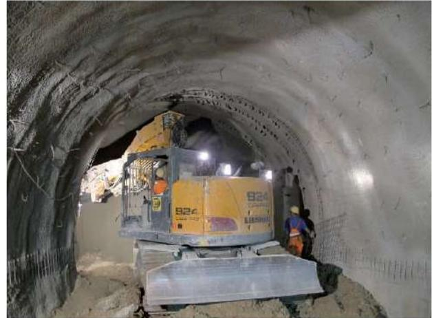
Bild 3. Tunnelbagger und Personen am Boden an der Ortsbrust
