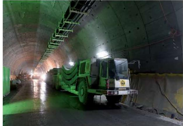
Bild 8. Transportgerät für Tübbinge
